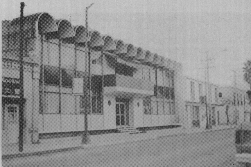
Edificio que ocupa actualmente la Presidencia Municipal de la ciudad de Gómez Palacio, Durango.
