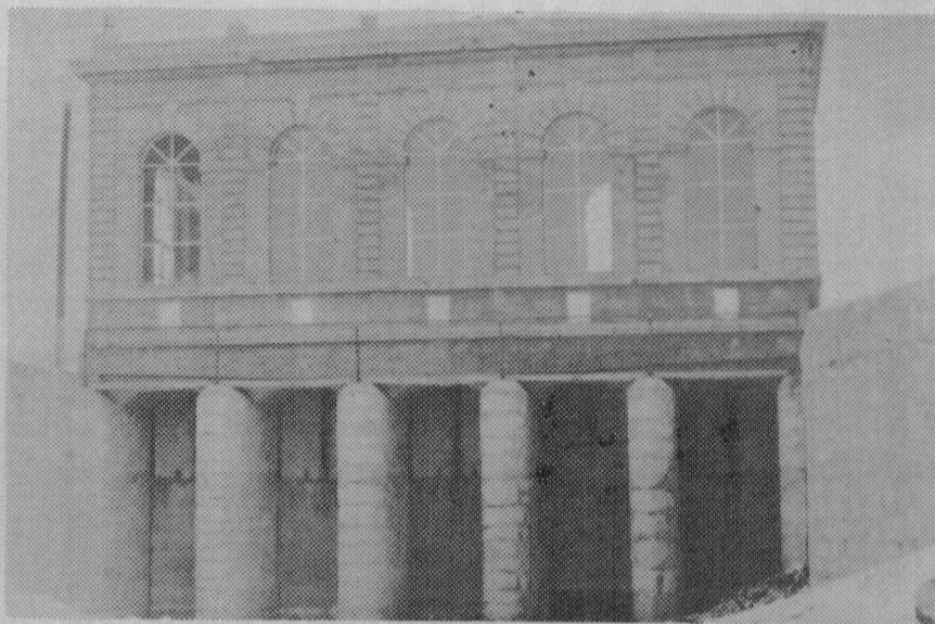
Caseta reguladora de la Presa del Coyote, construida en el año de 1853.
