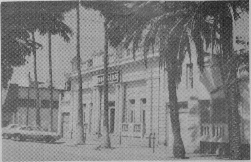
Edificio que ocupa el mas nobel de los periódicos laguneros "NOTICIAS" fundado en Torreón por el Ing. Antonio Dueñez Zurita el 13 de Mayo de 1975.
