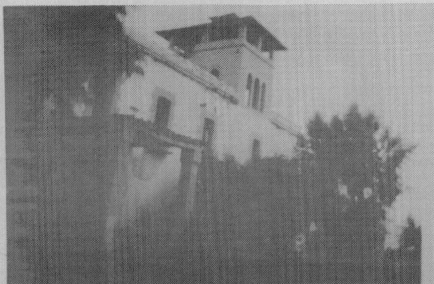
Aspecto actual de lo que fué la Casa grande de la Hacienda de Hornos, construida por Don Leonardo Zuloaga en el año de 1848.
